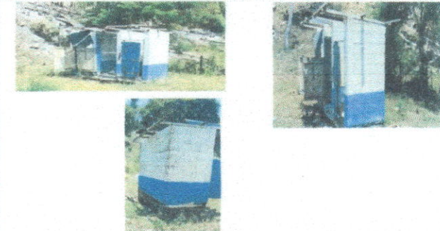
Foto 6: Letrina; Letrina en mal estado por las puertas, estructura y el techo
